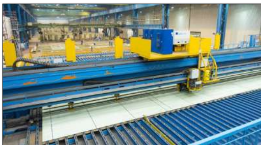
Figura 5. Instalación de soldadura de refuerzos mediante láser-híbrido en MEYER.
