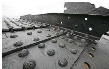
Detalle de remachado
